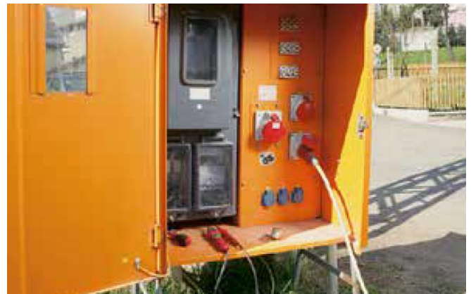
Bild 2 Bauverteilerschrank
