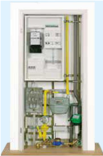
Bild 5 Beispieldarstellung: Platzsparende Hausanschlussnische Quelle: DIN 18012
